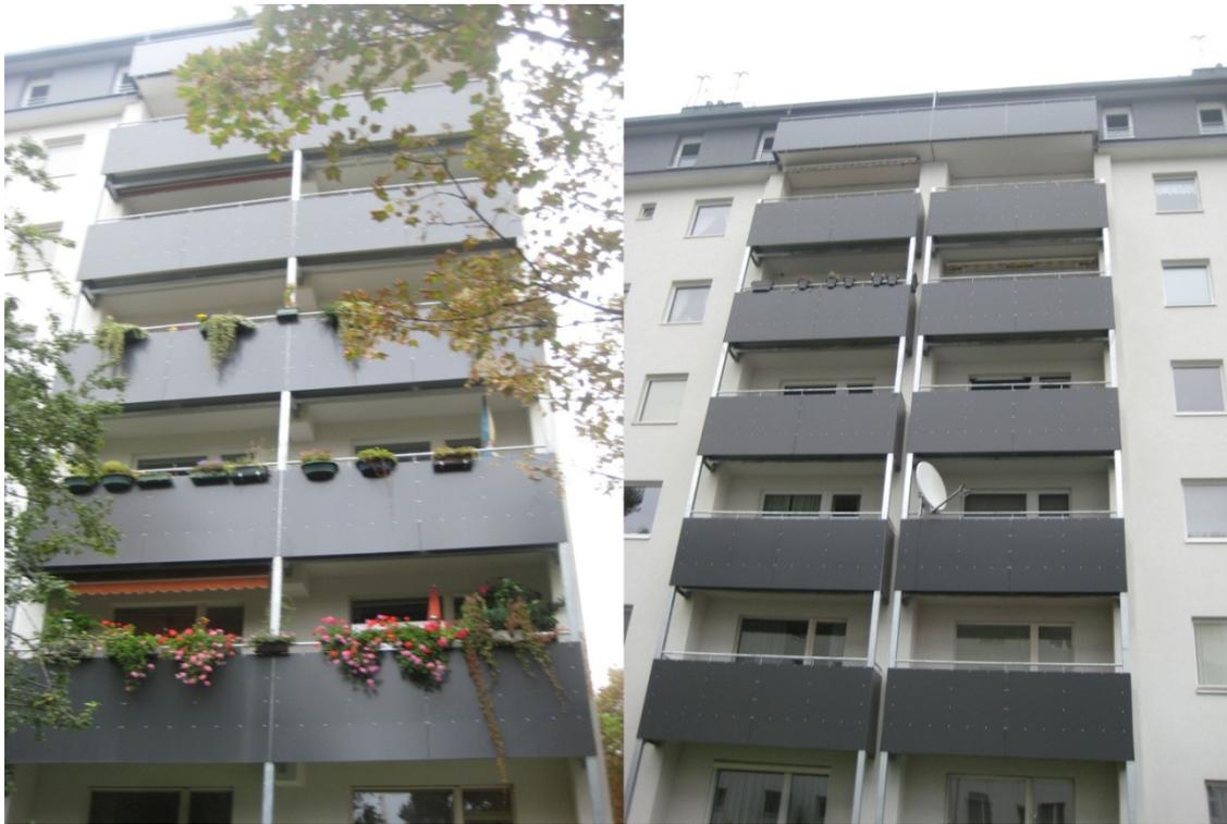
Im berühmten "Arsenal" in Wien hat man sich für Balkongeländer mit blickdichter MAX-Exterior-Beklankung entschieden. Diese sind auf Steher aus verzinktem Stahl genietet, wobei die Beplankung einfach oder wechselseitig für einen räumlichen Effekt erfolgen kann. MAX-Exterior-Platten sind in einer Vielzahl von RAL-Farben erhältlich.
