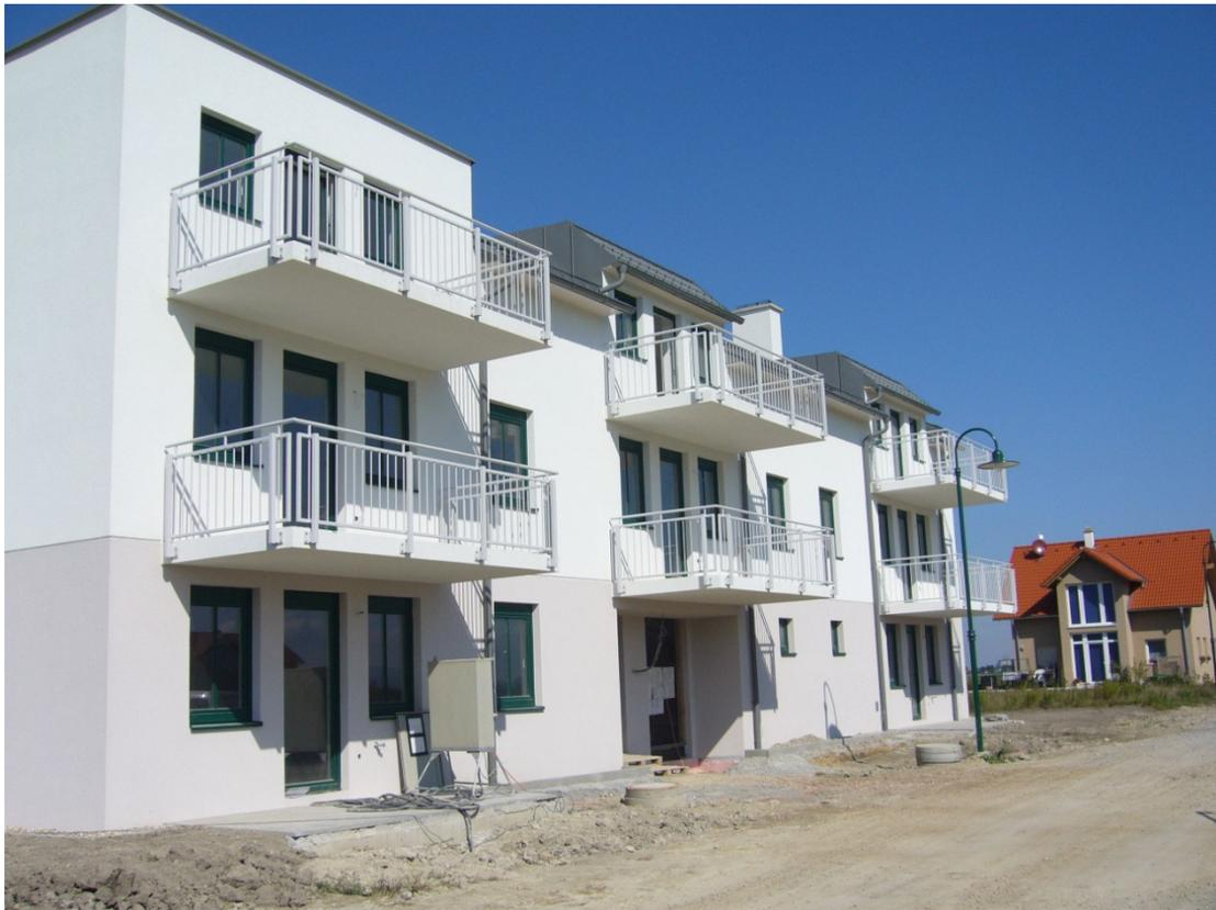
Stabgeländer lassen sich ebenfalls in vielen Varianten gestalten. Sie können mit runden oder eckigen Stäben, mit extra Handlauf oder integriertem Handlauf wie hier abgebildet ausgeführt werden. Diese Geländer wurden in RAL 9010 ("Reinweiß") pulverbeschichtet.
