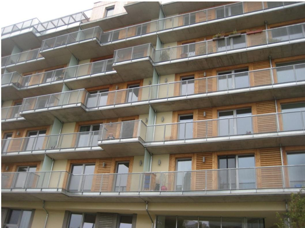
Dieses Beispiel zeigt Balkongeländer mit Streckmetallfüllung. Diese verzinkten Geländer wurden von uns im Stadtentwicklungsprojekt Eurogate auf den Aspanggründen in Wien in einem hochmodernen Neubau eingebaut.
