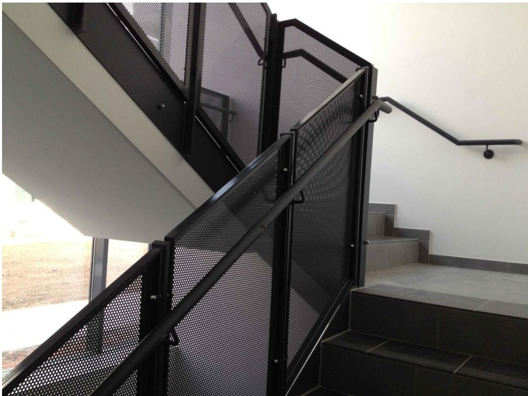
Auf diesem Bild sehen Sie Lochblechgeländer in RAL 7024 pulverbeschichtet. Durch die Lochblechfüllung sind die Geländer teilweise durchsichtig, und somit hervorragend für Balkone geeignet. Die Bleche sind mit verschiedenen Lochformen und -mustern erhältlich und können nach Belieben pulverbeschichtet oder lackiert werden.
